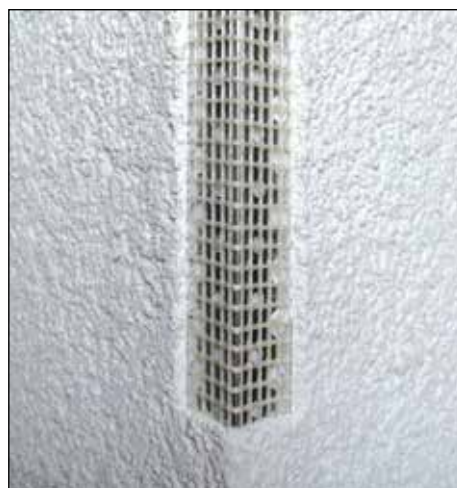
Detail umístění kombi lišty - řez
