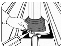
3. Nanesení těsnícího tmelu.
