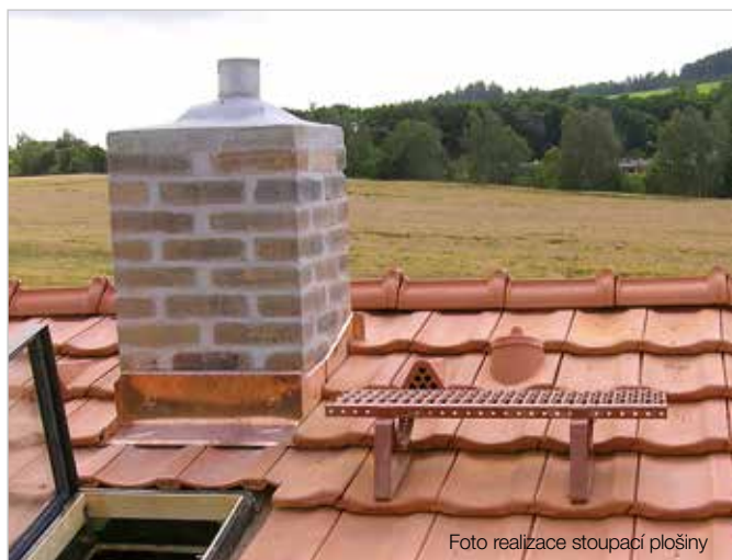
Ukázka instalace bezpečnostního háku Trapac®
