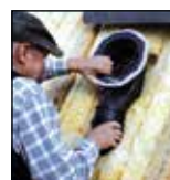
Venduct® prostup nadkroevní izolací pro rekonstrukce
