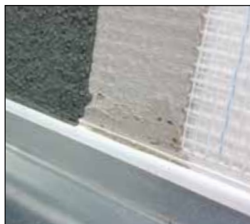
Foto realizace připojovacího profilu HPI - UNI
