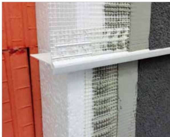
Ukázka realizace – Profil s okapnicí a tkaninou přechodový (850-20)
